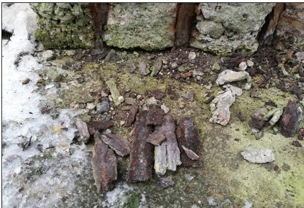
Obr. č. 17 - pohled na korozní zplodiny odstraněné z výztuže
