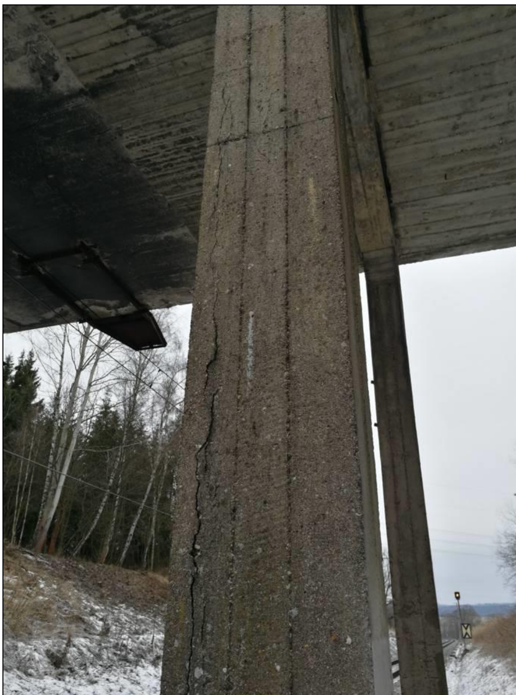
Obr. č. 10 - pohled na sloup 1 - svislá trhлина v líci
