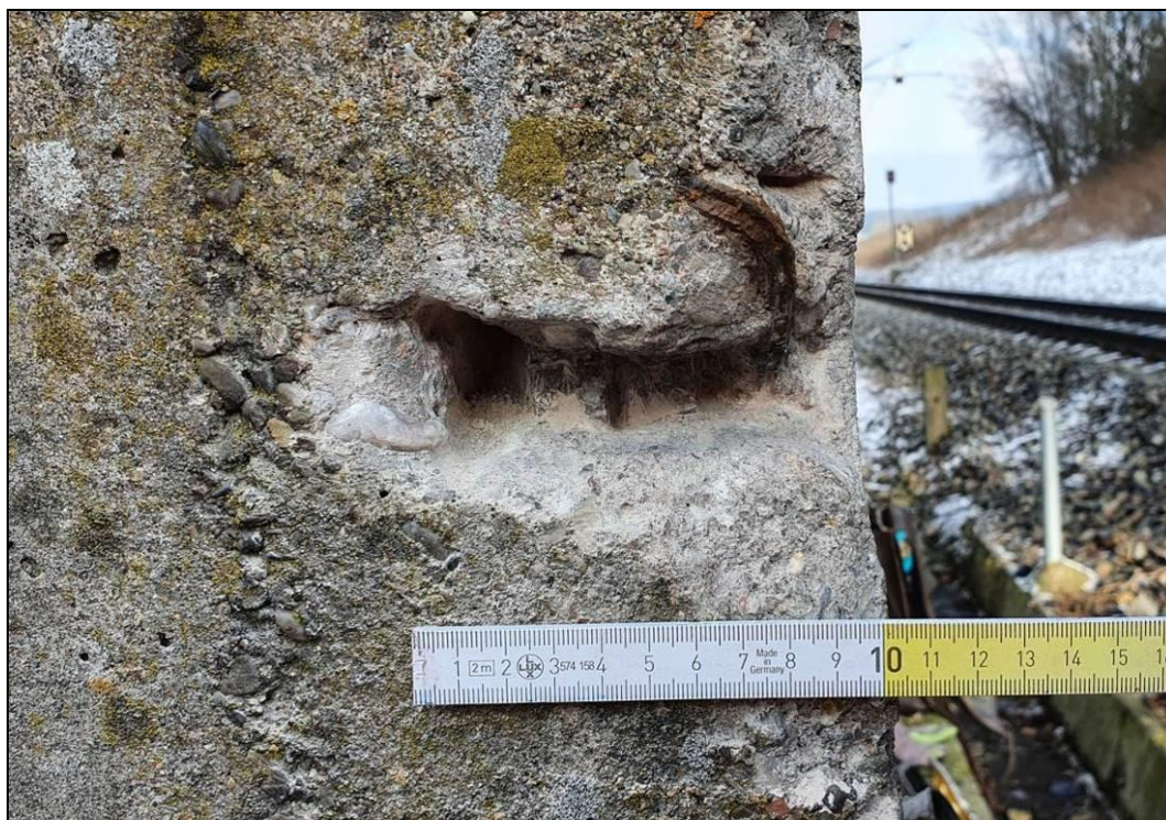
Obr. č. 13 - destruktivní bodová sonda DRS2 do sloupu 2
